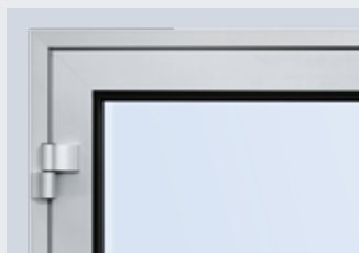
Vedere din interior cu vitrare din material plastic
